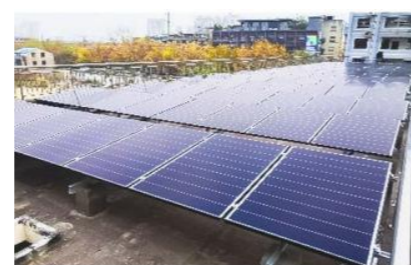
2020年11月,为湖北襄阳十二中捐赠了60kW屋顶光伏,项目于2021年2月并网,年发电量6万度。
